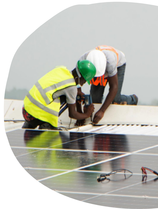
Verlegung der Solarmodule auf dem Dach der Schokoladenfabrik in Ghana, Foto: fairafric
